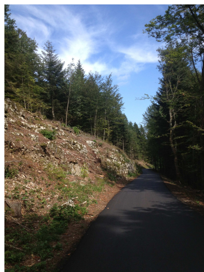
Route après coupe de bois et réfection
