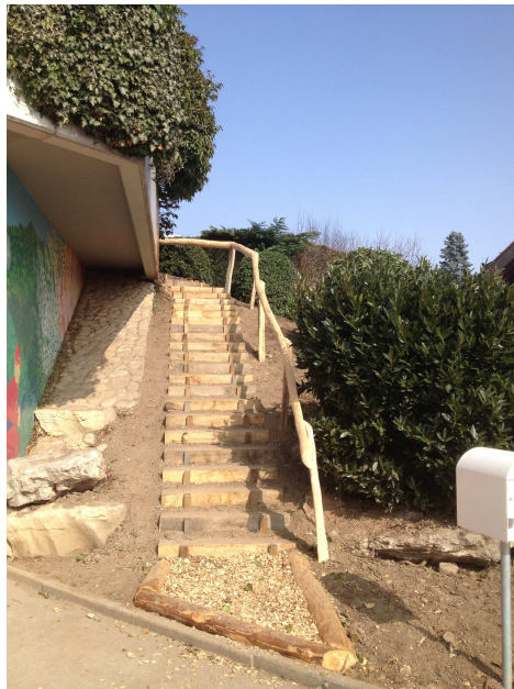
Création d'un escalier pour la Commune de Givrins
