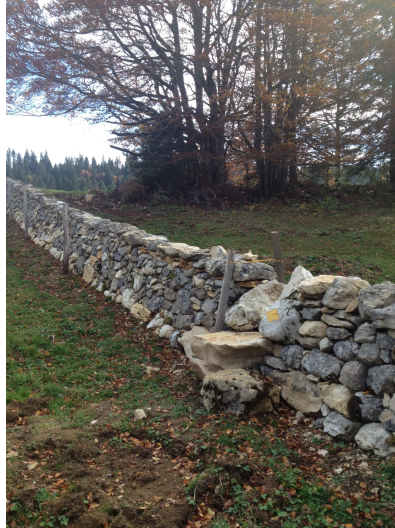
Mur Coppettes-Baronne avec réfection passage piétons
