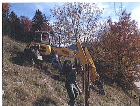
Clôtures, plantation de pieux avec Menzi
