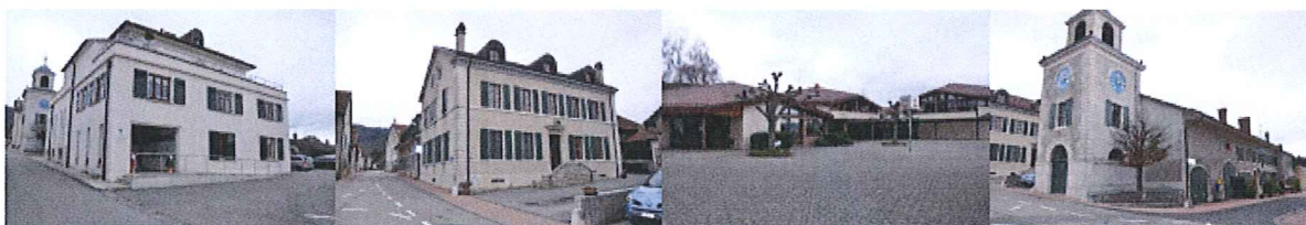
Bâtiments communaux connectés (la salle communale, l'administration, l'école, la tour).
