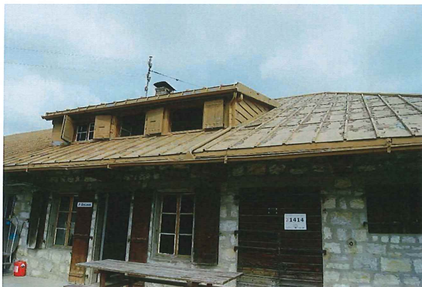
Pan sud-est de la toiture
