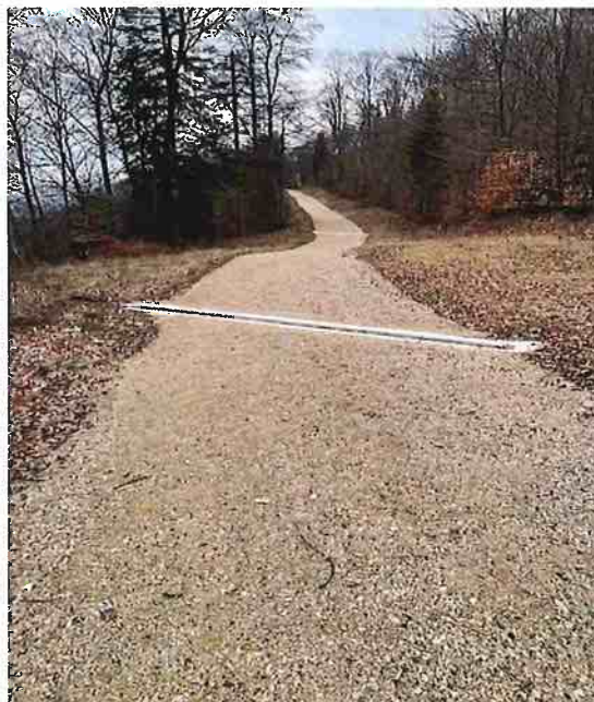
Photo d'un chemin rénové à l'identique, en 2023, sur la Commune de Genolier
