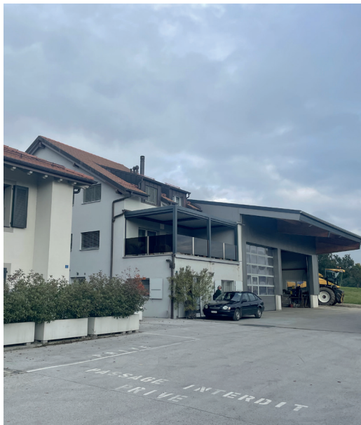
logement et hangar (M. David Prélaz)
