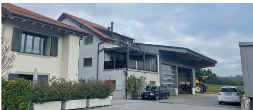
Construction du logement et de l'activité de M. Prélaz sur le site, occupant largement et rationnellement la zone à bâtir actuelle
