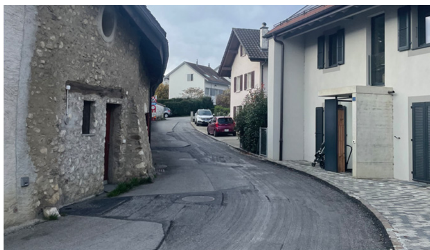
3 Accès au site depuis du Carre au nord-ouest de l'activité de M. Prélaz
