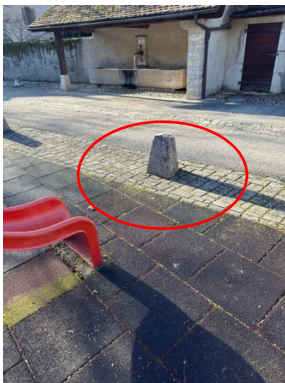
Borne à la sortie du jeu, non conforme
