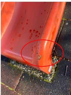
Surface du toboggan abimée, risque de blessure avec des échardes de fibres de verre
