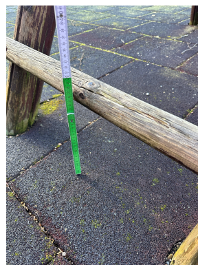
Barreau à moins de 40 cm du sol
