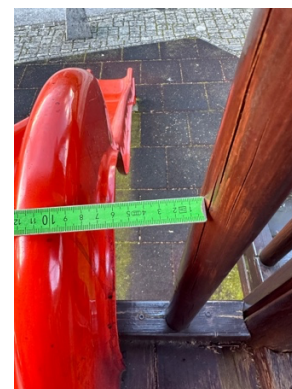
Surface du toboggan abimée, risque de blessure avec des échardes de fibres de verre
