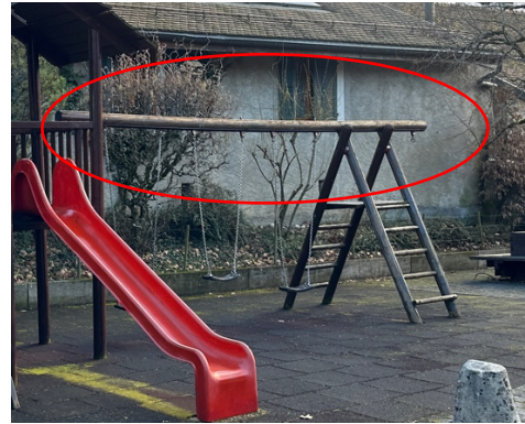
Déformation du portique supportant les balançoires
