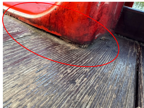
Points de coincement à l'entrée du toboggan, déformation de l'engin et signes de détérioration importants
