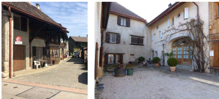
Exemples de cours à préserver (aires de cours sur rue) à Givrins
