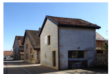
Front bâtis, route de la Bellangère
