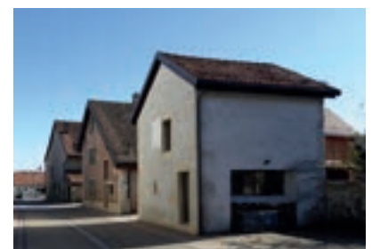
Front bâtis, route de la Bellangère
