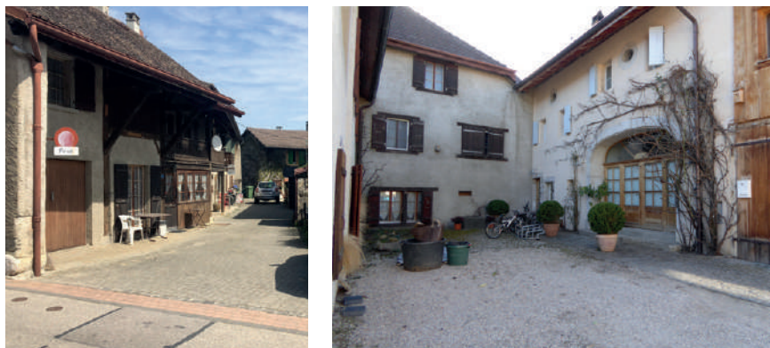
Exemples de cours à préserver (aires de cours sur rue) à Givrins
